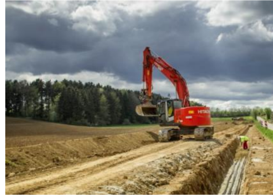
Gleichstrom-Erdkabel-Verlegung
